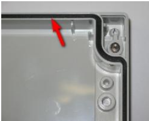
Рис.2.6-3. Резиновый уплотнитель в крышке
